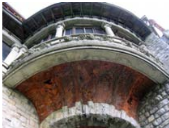
Fig.10: Brickwork bracket. Restaurant, Campo dei Fiori
